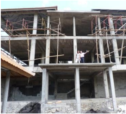
Achterzijde nieuwbouw okt.'11
