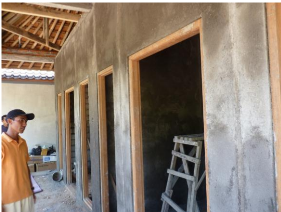
2 gastenkamers in aanbouw
