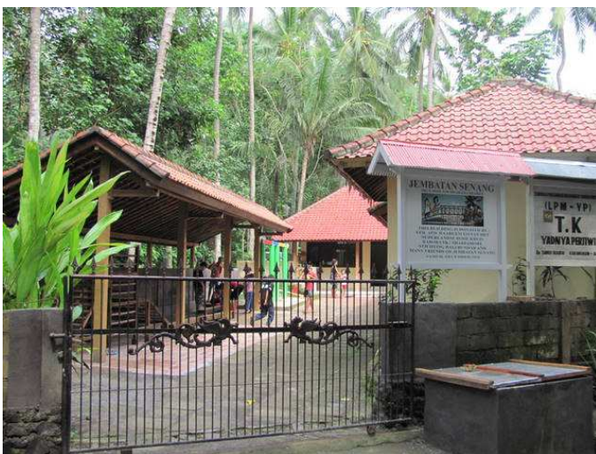
Vanaf de straat, het nieuwe afdak met daarachter de nieuwe vleugel voorzijde.
